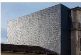
Figura 70 - Revestimento em soletos de ardósia do novo volume. Fonte: César Machado
