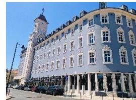
*Figura 136 - Fachada Nascente onde é possível observar os vãos rasgados no embasamento e as trapeiras adicionadas na cobertura.*
