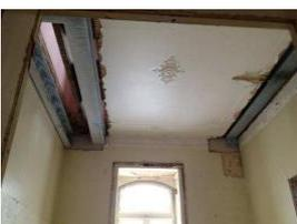
Figura 81 - Revestimentos de tecto atravessados por perfis metálicos. Fonte: A2P
