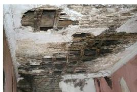
Figura 60 - Tecto com estrutura de madeira à vista e estuque degradado. Fonte: César Machado
