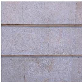
Figura 129 - Revestimento a pedra lioz embasamento e Torre do Relógio.
