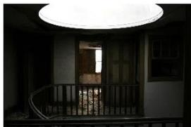
Figura 62 - Lanternim de iluminação da caixa de escadas nº 430. Fonte: César Machado
