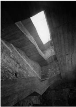
Figura 127 - Escada norte com paredes de alvenaria de pedra e lajes de betão armado. Fonte: Fundação Portuguesa das Telecomunicações
