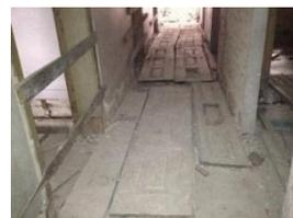
Figura 82 - Portas e portadas de janelas removidas. Fonte: A2P
