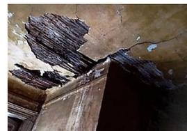
Figura 103 - Deterioração dos madeiramentos e queda de estuque por entrada de água na cobertura.
