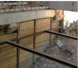
Figura 79 - Arcos de fundação de parede existente, sistematicamente cortados. Fonte: A2P
