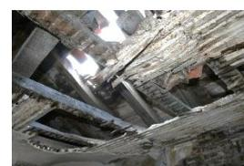
Figura 61 - Cobertura sem telhas e com estrutura degradada. Fonte: César Machado
