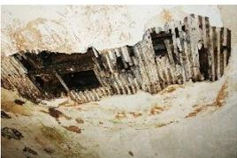
Figura 52 - Ripado sob os vigamentos de madeira dos pavimentos. Fonte: César Machado
